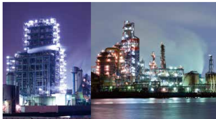
昭和電工川崎事業所の夜景。 東亜石油京浜製油所のプラント群の夜景。
